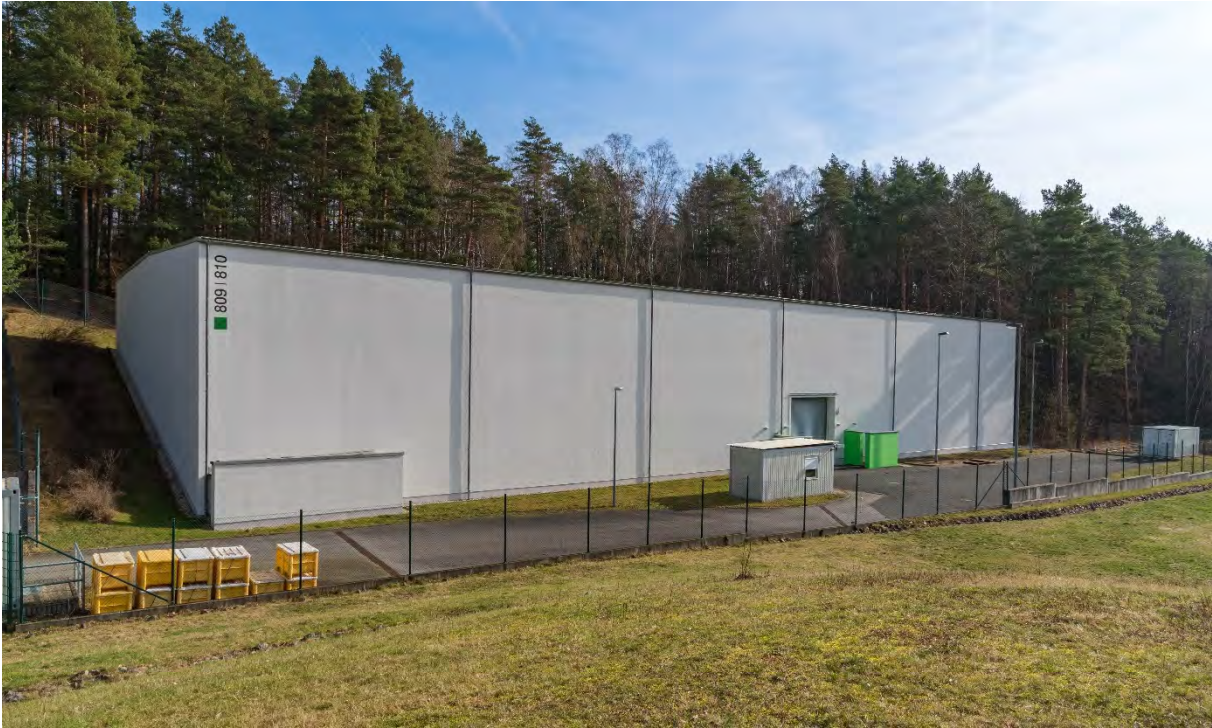
Abbildung 3-7: Sanierte Außenfassade des ZLR (Stand Ende 2023)
