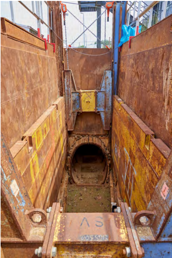
Abbildung 3-2: Blick auf den Eingang des Stollenverbaus
