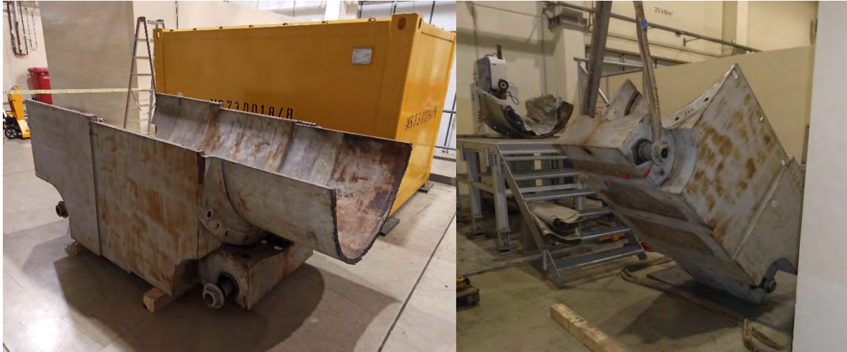
Abbildung 3-4: Zerlegung und Beprobung des Wagens der Thermischen Säule des RFR (nach Entnahme aus einem im ZLR eingelagerten Konrad-Container (KC))
