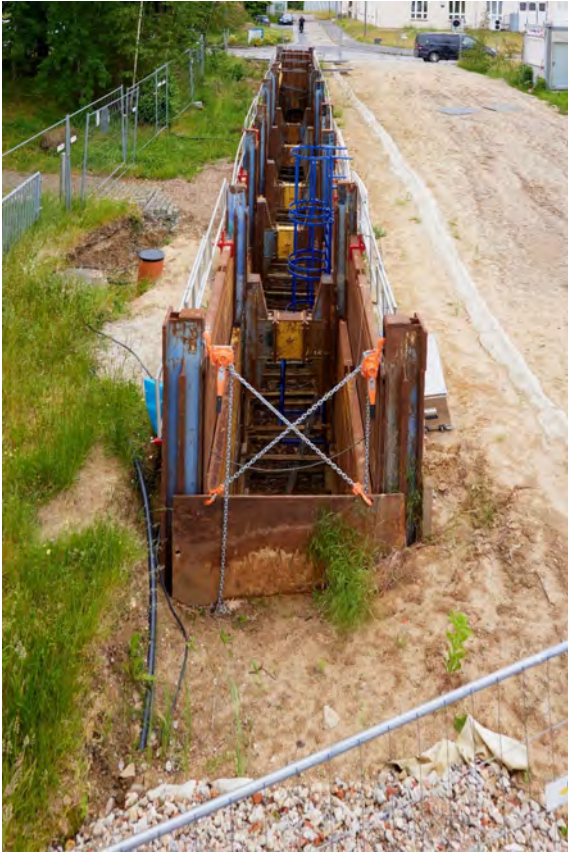
Abbildung 3-3: Blick auf den Gleitschienenverbau
