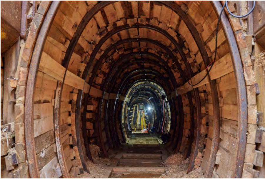
Abbildung 3-1: Blick in den Stollen
